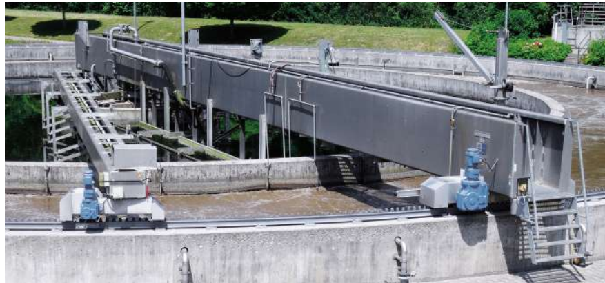
Schildräumer mit Vorläufer-Tauchschildbrücke und Zwangsantrieb
