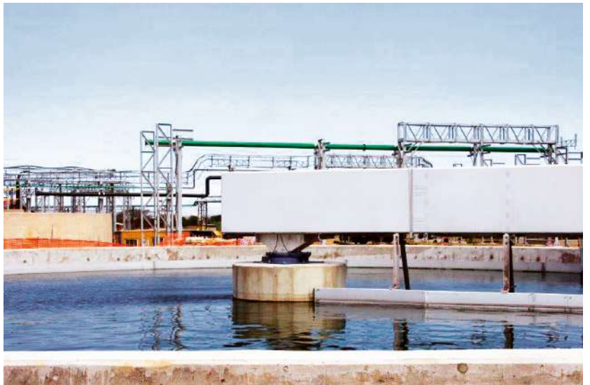
Schwimm- schlammräu- mung mit Skimrinnen
