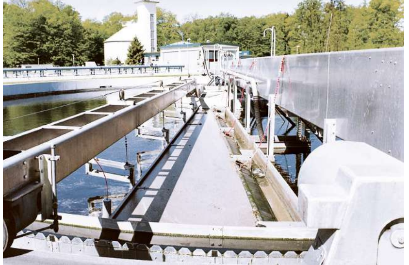
Schwimm- schlamm- räumung mit Vorläufer-Tauch- schildbrücke
