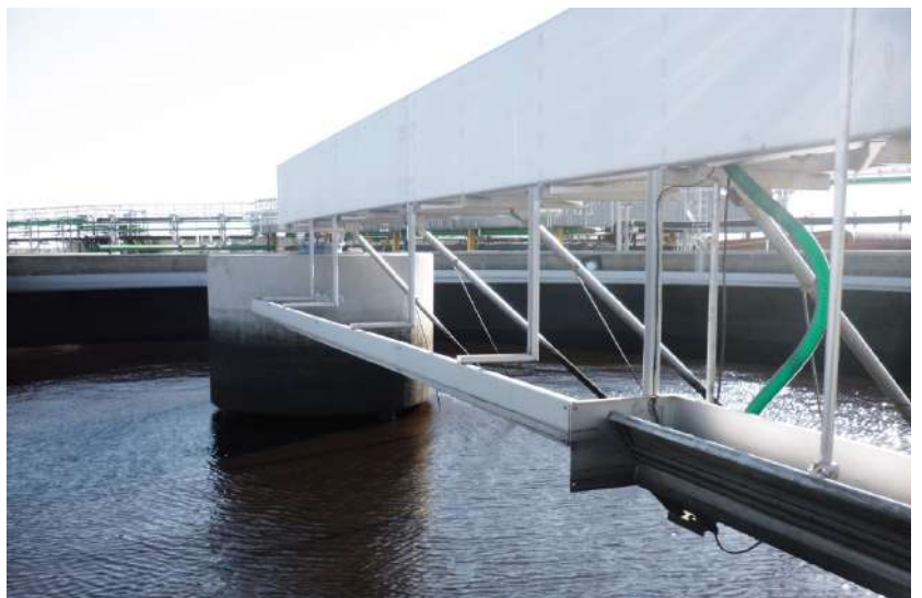
Schwimm- schlamm strömt über einstellbare Kante in Rinne
